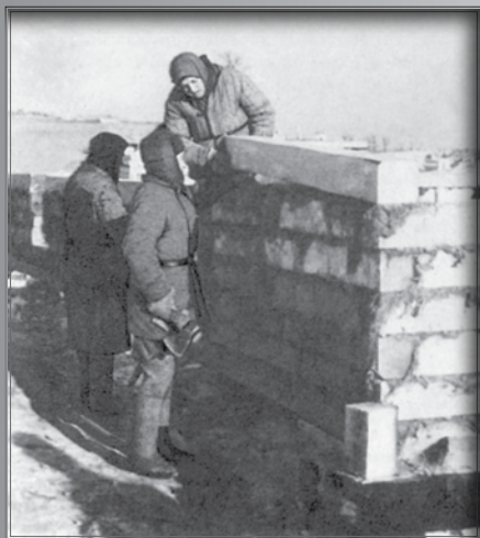
Строят новый дом
