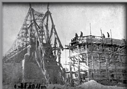
Восстановление Старого Волжского моста в г. Калининe
