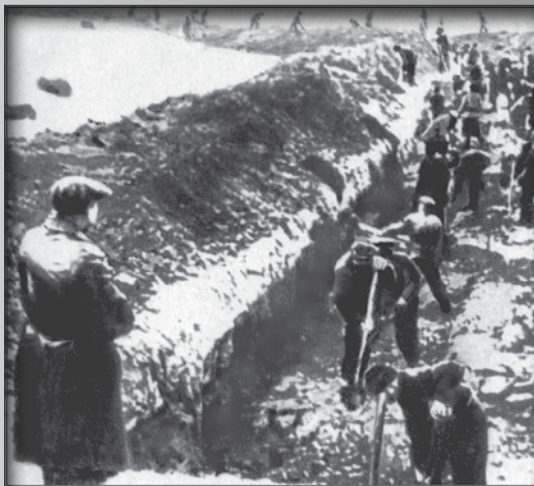
На строительстве оборонительных сооружений
