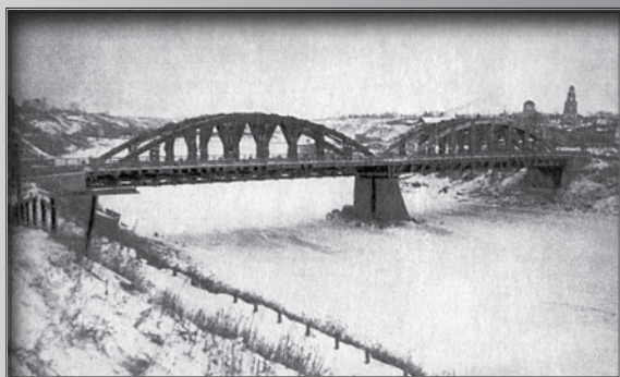
Мост через Волгу во Ржеве восстановлен
