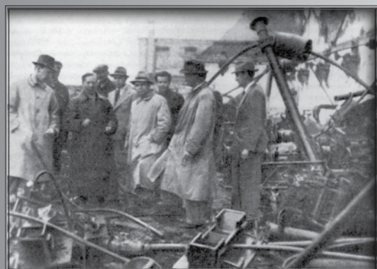
Американцы в разрушенном цехе Калининского вагоностроительного завода. 1942 г.
